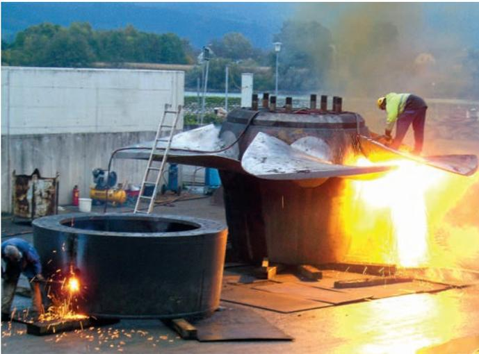
Die Demontage der alten Kaplan-Turbine beim Verbund-Kraftwerk Ybbs-Persenbeug. *Fotos: Firma Schaufler*
